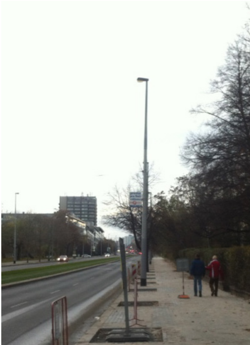
Chodník podél ulice Evropská. Foceno v době oprav.
