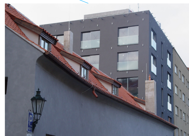
Objekt hotelu ve výstavbě.
