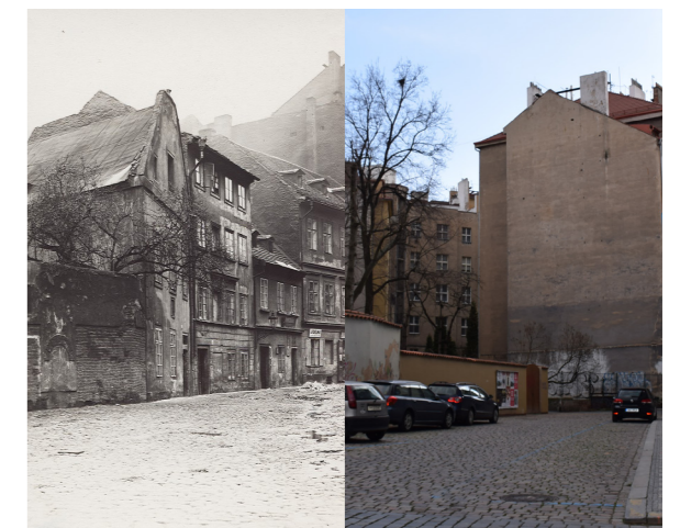
Porovnání fotografií před a po vybourání (ul. U Obecního dvora).
